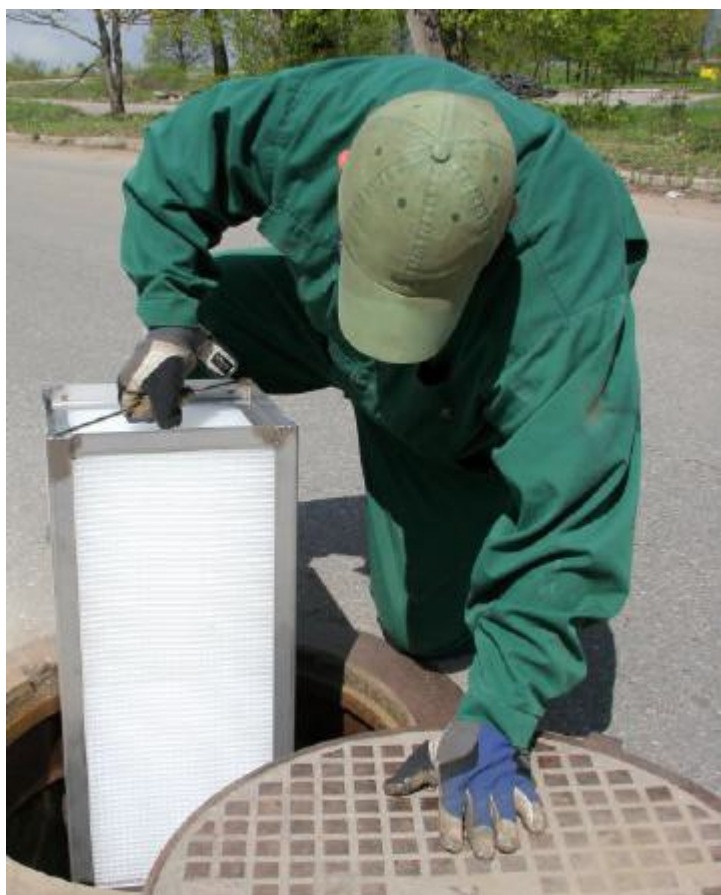
Illustrasjon 15. Løfting av koalescensmodulen
